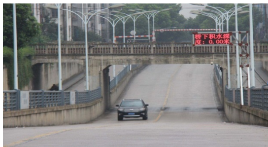
余姚市下立交积水监测显示屏
